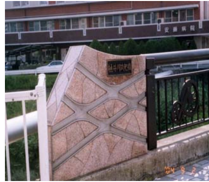
樋井川筑肥橋
