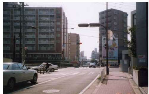
樋井川筑肥橋
