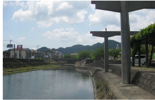
走行クレーン跡
