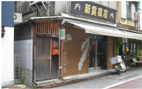
新実商店（米穀：昭和初年に建築、二軒長屋：北品川 2-4）
