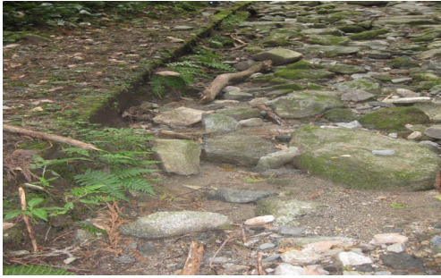
側溝跡：旧三瀬街道
