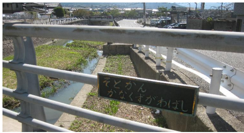
写 2-19 外環金屑川橋 (そとかんかなくすがわばし)
