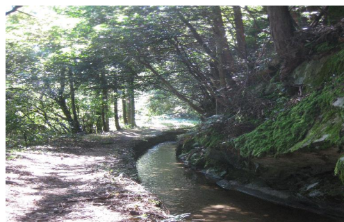
写 29 吊溝の流れ 3
