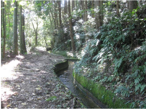
写 27 吊溝の流れ 2
