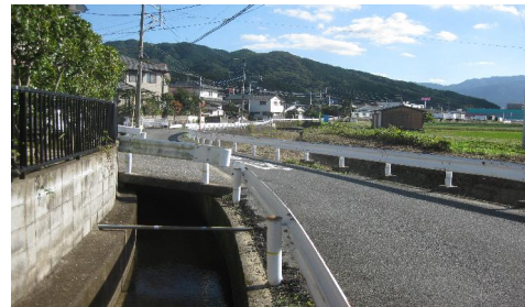
写 1-24 金屑川から取水された樺水路
