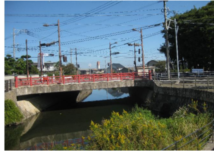
写 2-24 新開橋（しんびらきばし）付 近からの賀茂橋
