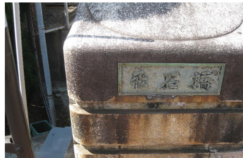
写 4-20 飛石橋 (金屑川：旧稲塚川、旧油山川)
