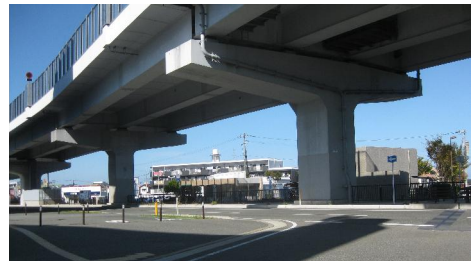
写 2-20 外環金屑川橋
