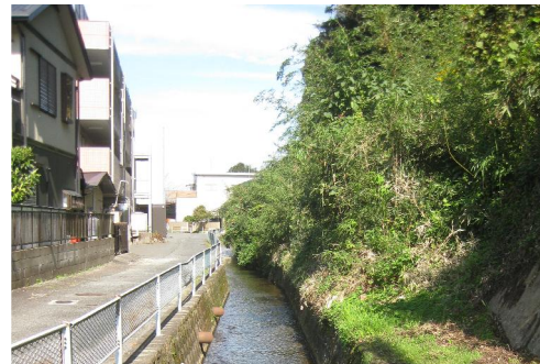
写 1-8 早良区東入部 8-13 付近
