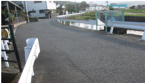
写 1-23 金屑川との合流点（門貫橋）と取水口
