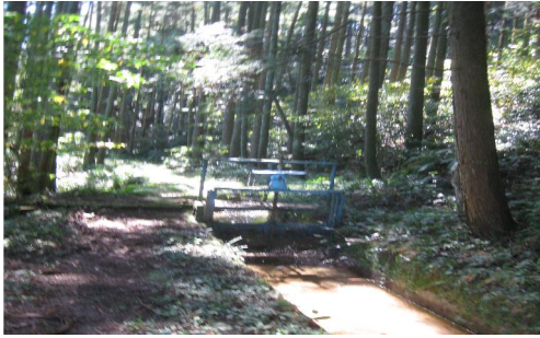
写 31 吊溝（椎原川からの取り込み水門）
