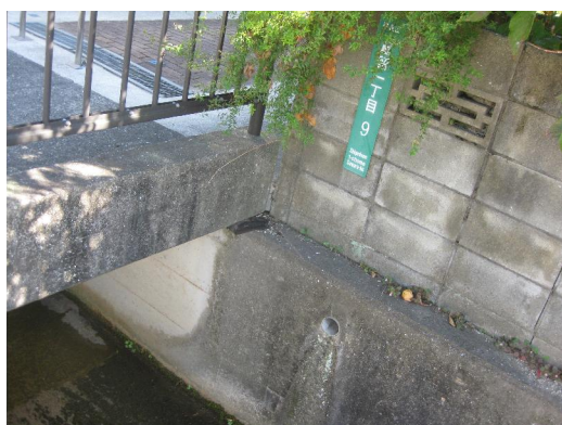
写 2-3 早良新町公園前付近
