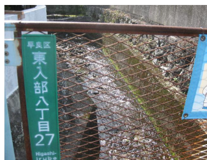
写 1-4 136 号線を横断した椿水路を横断した椿水路
