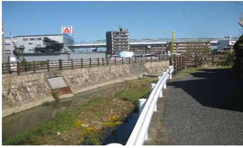
写 2-23 水町橋付近
