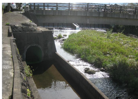
写 1-2 椿水路への取水口 (東入部 8 丁目 26) 付近
