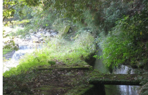
写 32 左は椎原川、右は吊溝（取り込み口）
