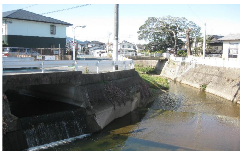
写 4-1 旧稲塚川 (現油山川：飯倉 7-20 付近)
