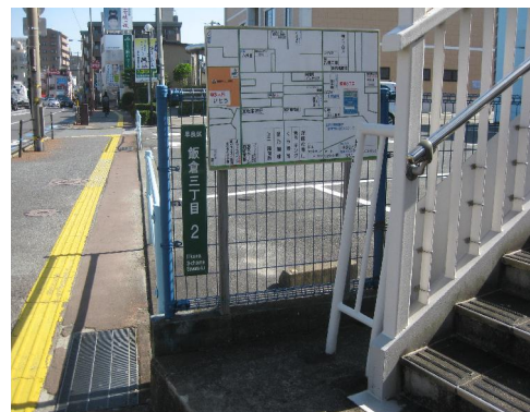
写 4-10 202 号線荒江 3-2 付近の陸橋
