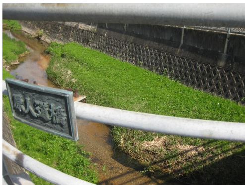
写3-3 原人道橋（はらじんどうきょう：飯倉小学校裏）
