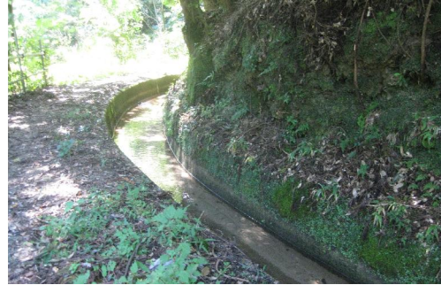
写 26 吊溝の流れ 1
