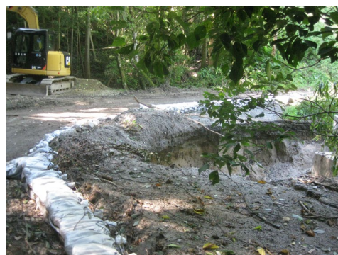
道路崩れのカーブ (工事中) 1610 歩 : 187m
